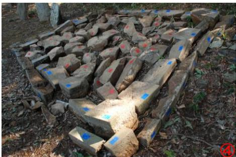
④土台の石工事が始まりました。地盤工事のため、石敷きを外す際、元の位置に戻せるよう番号を記したテープが貼られています。今回の工事では、地盤の歪みを直して補強し、水はけを良くし、さらに盛土をして、実氏霊屋の屋根との接触を避けるため、建物の位置を少し上げています。
