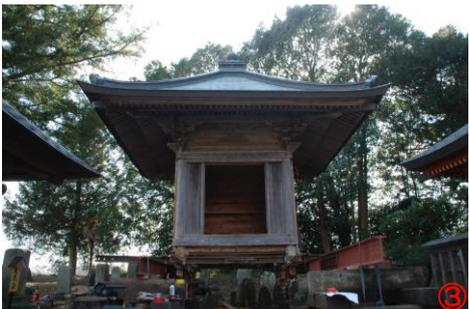
③霊屋の揚げ屋工事です。霊屋下の土台(石)工事のため、建物が高さ1mほどまでジャッキアップされました。平行を保っているか確認しながら木材を組んで仮土台にしています。また、扉が取り外されているのも確認でき、この時点で床板も外されています。普段見ることができない光景です。
