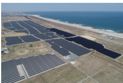
▲亘理太陽光発電所
