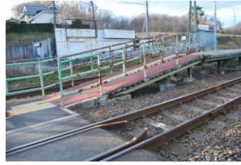
⑤スロープ・誘導用ブロック
