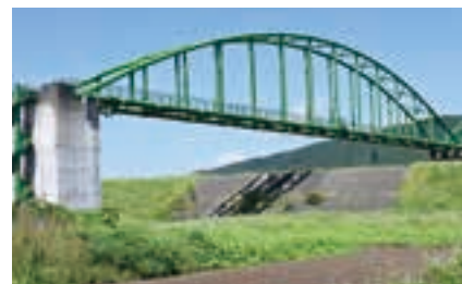
県水管橋（阿武隈川）
