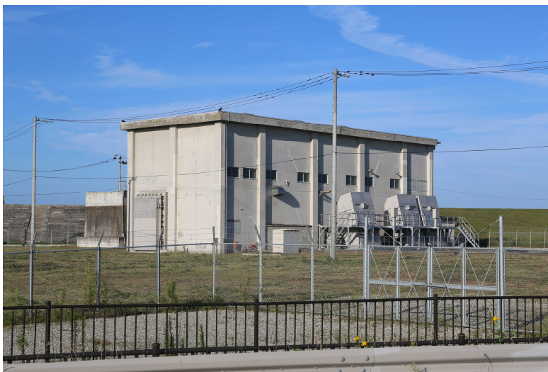
写真 荒浜雨水ポンプ場
