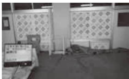
小学校断熱改修
