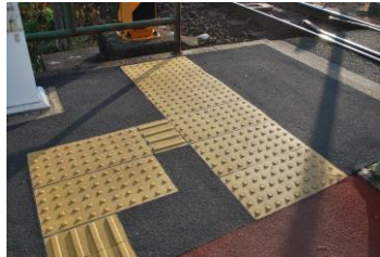
③誘導用ブロック
