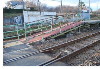
⑤スロープ・誘導用ブロック
