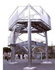
避難タワーの設置
