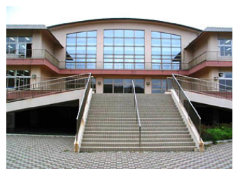
津波対策を講じた学校施設
