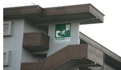
公営住宅等の屋上等の活用
