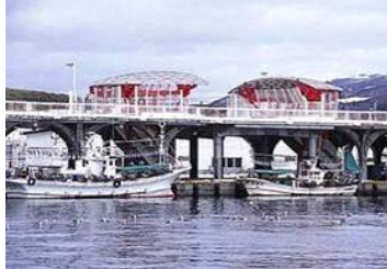
津波対策を講じた漁港施設
