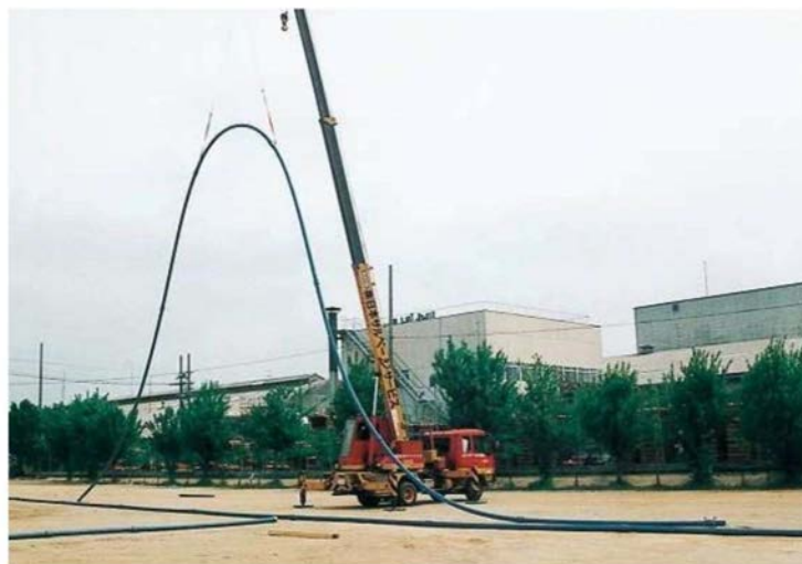
[写真：配水用ポリエチレンパイプシステム協会より]
