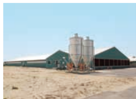
完成した繁殖養豚施設外観
