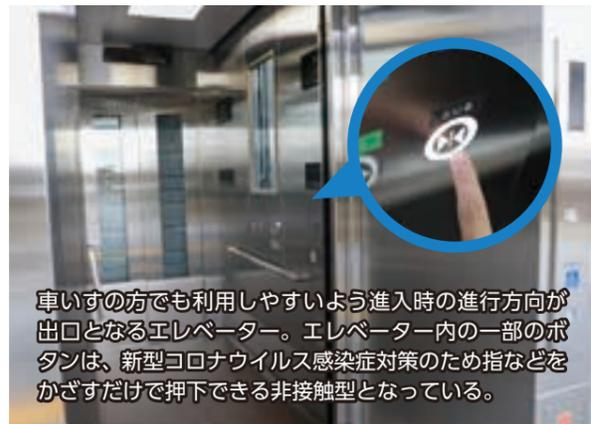
車いすの方でも利用しやすいよう進入時の進行方向が出口となるエレベーター。エレベーター内の一部のボタンは、新型コロナウイルス感染症対策のため指などをかざすだけで押下できる非接触型となっている。
