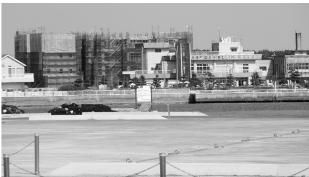
着々と工事が進む「わたり温泉鳥の海」
