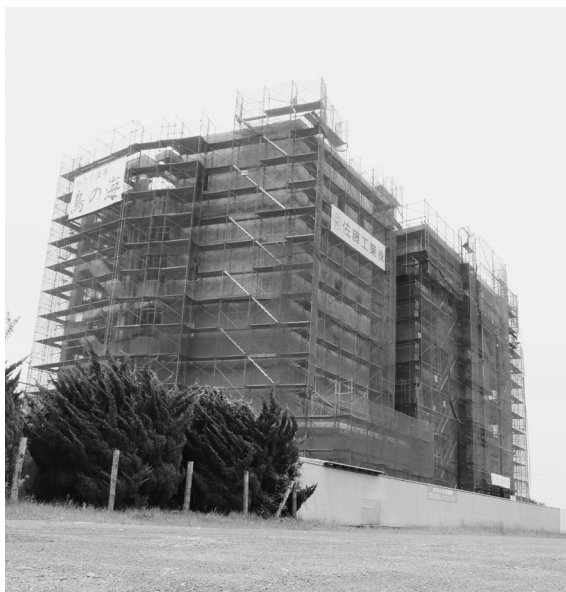
着々と工事が進む「わたり温泉 島の海」
