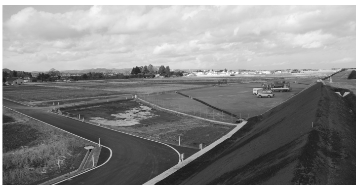
工事中の常磐自動車道の上から見たパーキングエリア建設予定地（高屋）
