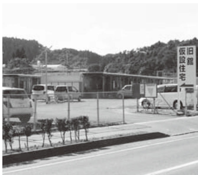
旧館仮設住宅
