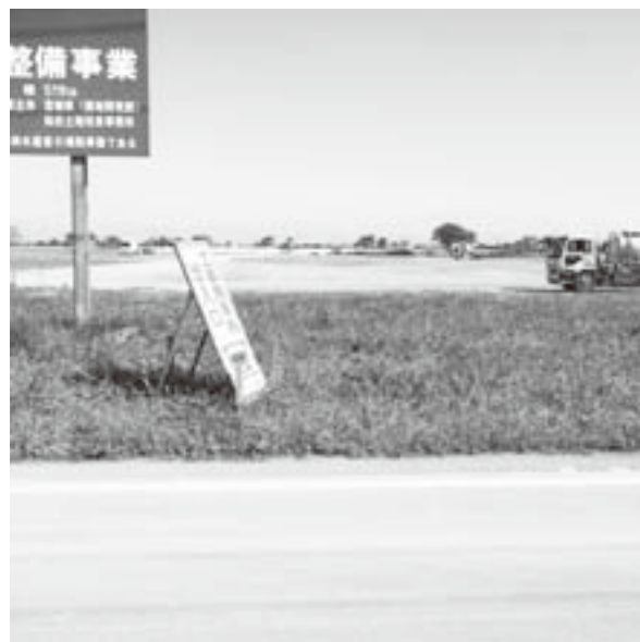
進出企業の造成工事現場（亘理中央工業団地）
