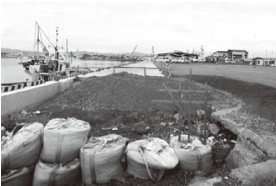
復旧工事中の荒浜漁港
