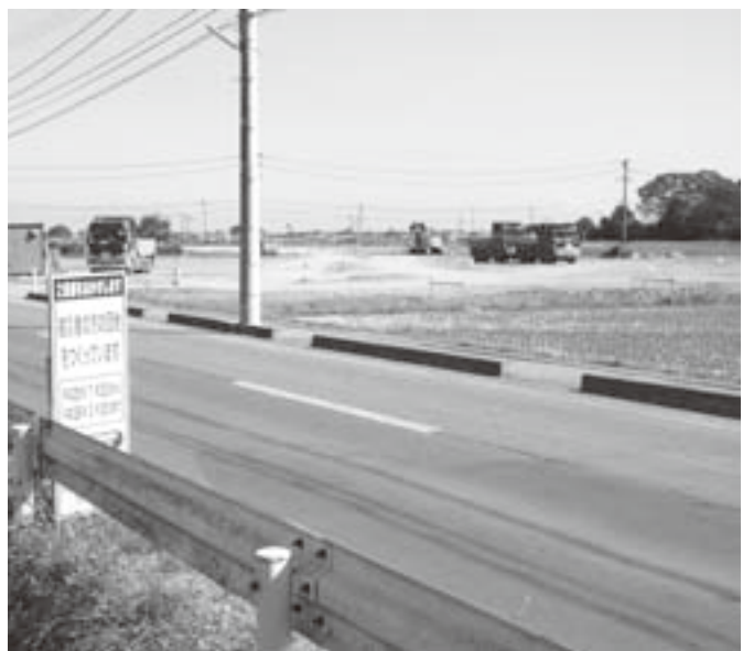
災害公営住宅上浜街道の整地工事
