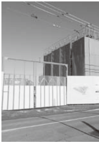
建設中の災害公営住宅（荒浜西木倉）
