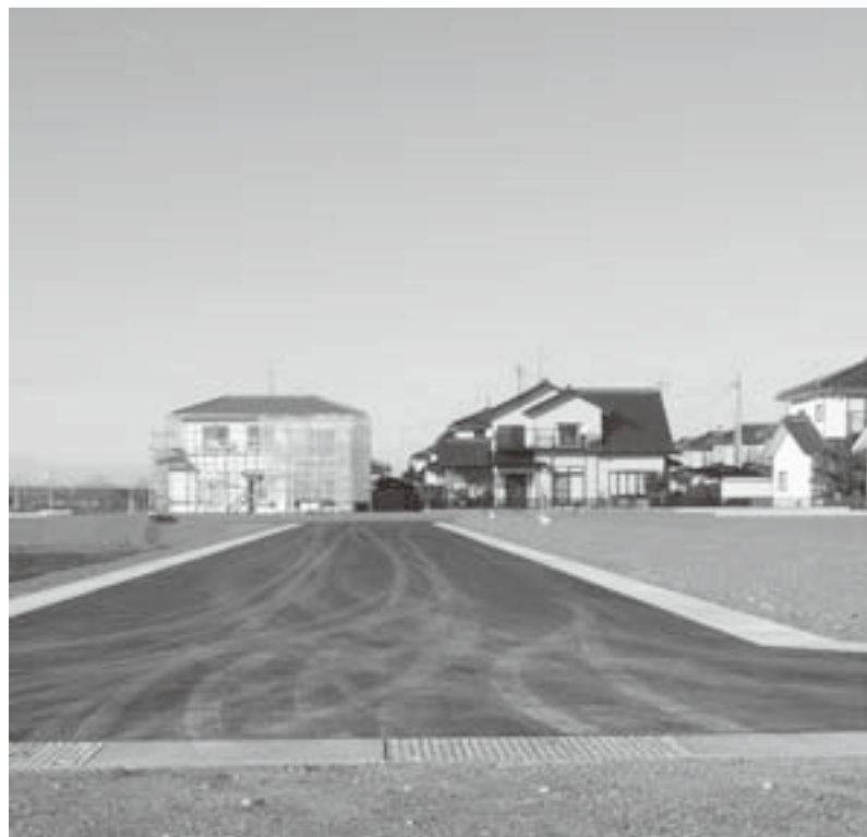
盛土工事が完了した防災集団移転団地（吉田上塚）
