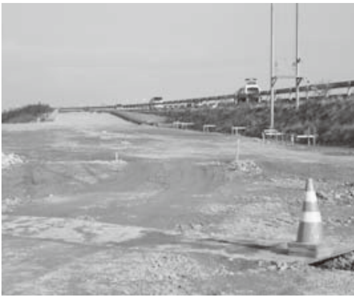
巨理パーキングエリア・スマートICの建設現場
