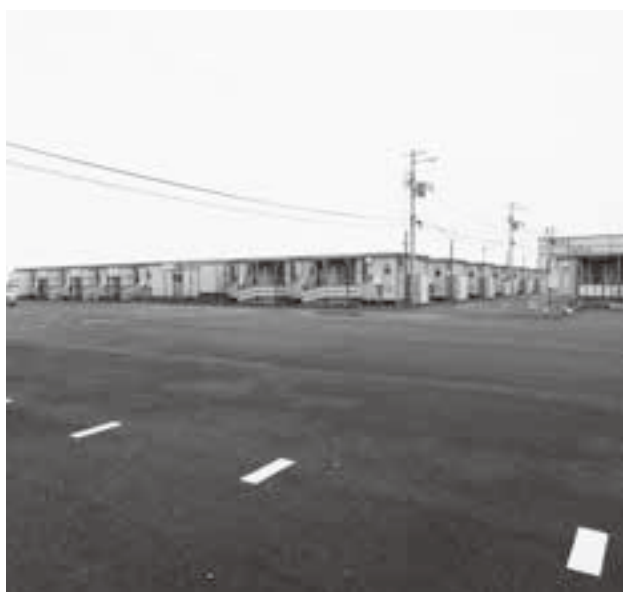
中央工業団地仮設住宅
