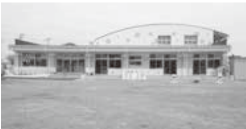
完成した荒浜保育所
