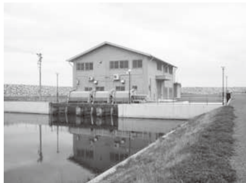
吉田浜排水機場
