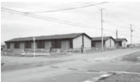
水産加工流通施設（漁具倉庫）
