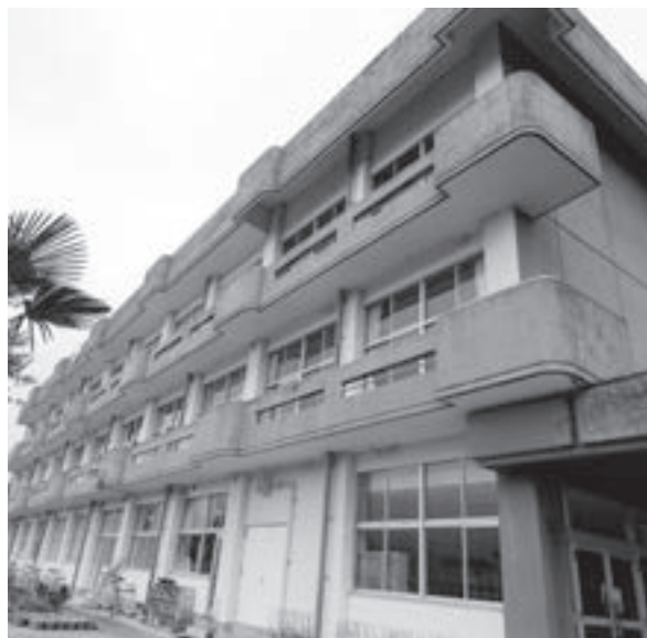
外壁工事が行われる吉田小学校
