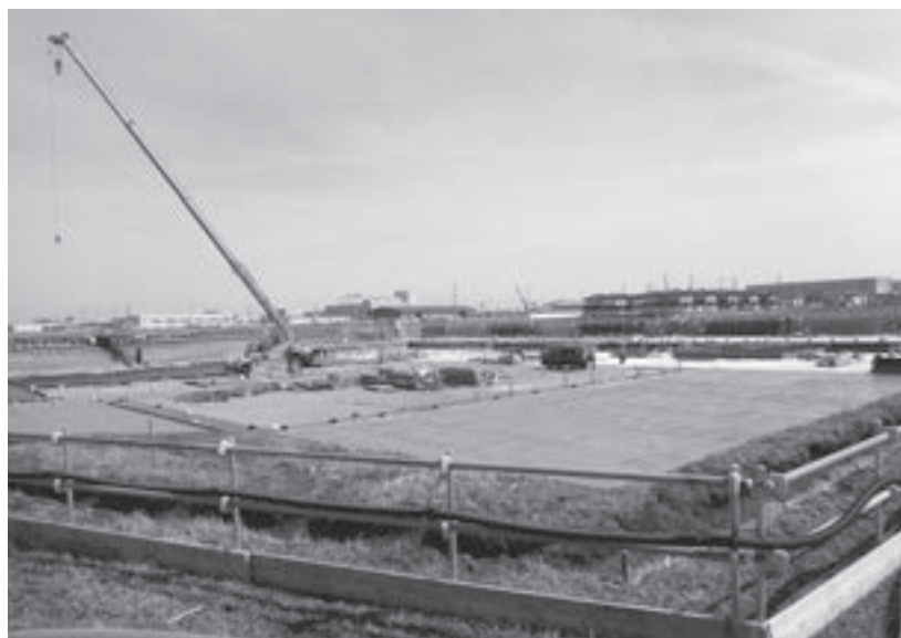
役場新庁舎建設中
