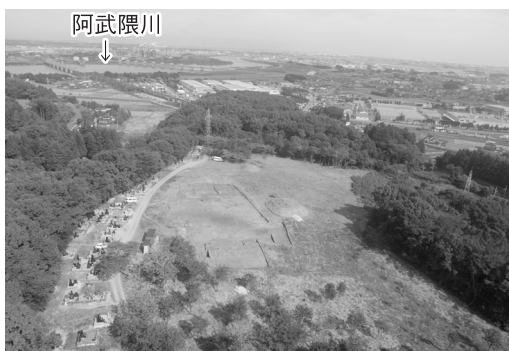
上空南から見た三十三間堂官衙遺跡(奥が阿武隈川)
