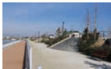
完成した公園と釣りデッキの様子
