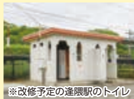
※改修予定の逢隈駅のトイレ
