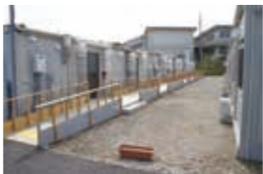
▲【2011年4月29日】 最初の仮設住宅「館南仮設住宅」が完成
