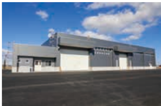
平時時も防災関係の講習会や訓練に使用できる防災倉庫
