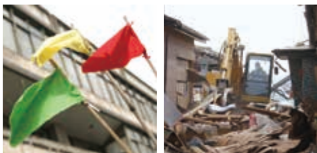
▲【2011年4月18日】 所有者の意思を表す色付きの旗を掲げたことにより、がれきの解体撤去作業はスピーディーに進められた
