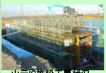
山元IC施設工事状況
