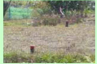
幅杭の打設状況
