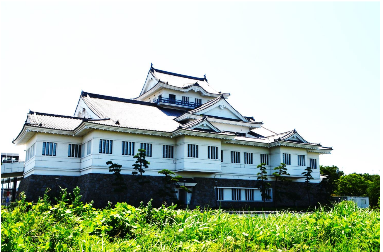
悠里館(東から)
