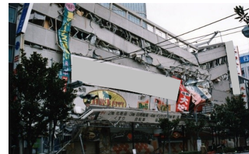
地震により崩壊した大規模店舗 (写真提供:神戸市、国土交通省にて一部加工)
